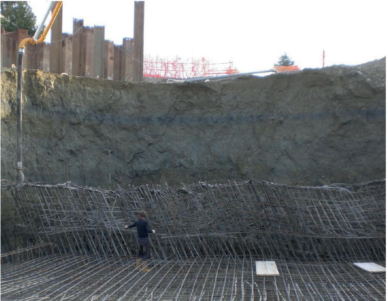
Fig. 76 – Il livello paludoso (scuro) osservato in una parete di scavo, a profondità di – 3,3 m, durante i lavori per il sottopasso ferroviario a Lugo nel 2009
