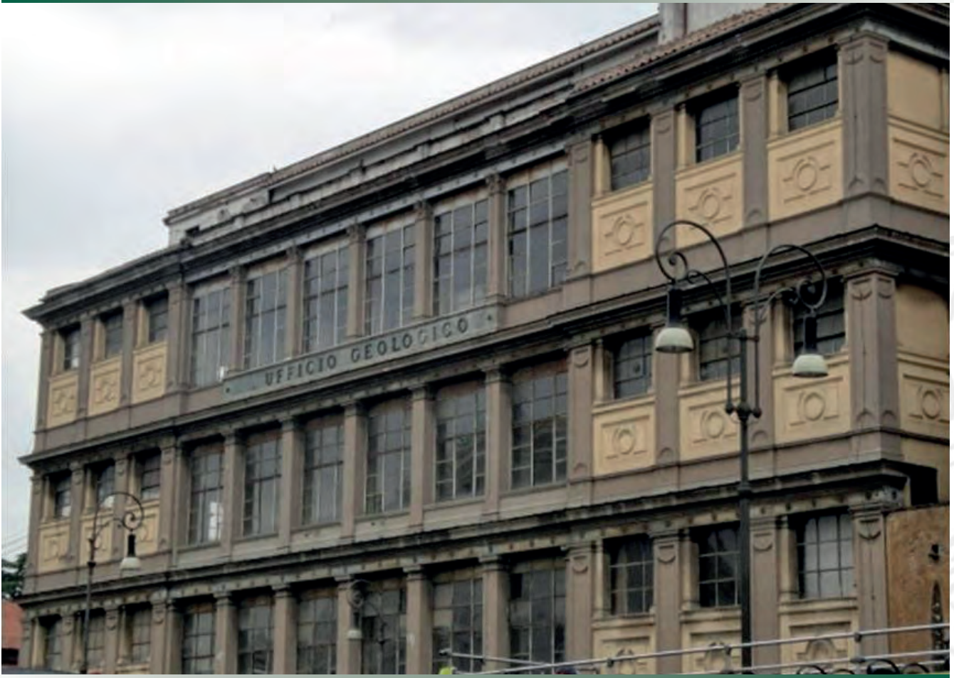
Figura 2 - La facciata dell'edificio di Largo Santa Susanna, fino al 1995 sede del Servizio geologico d'Italia.
